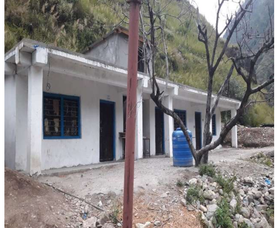
तस्विर ने.रा आ.वि छायाल भवन निर्माण (लागत ३८००० )
