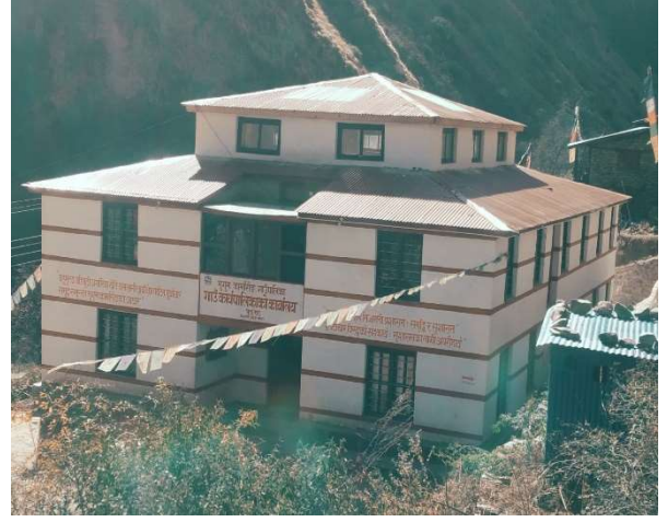
तस्विर गा.पा प्रशासकीय भवन (लागत ८६८७०००)
